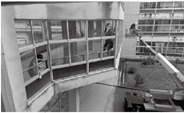
クレーン車2台（12m、27m）による窓ガラス清掃 （松江市立第四中、2021.10.17）
